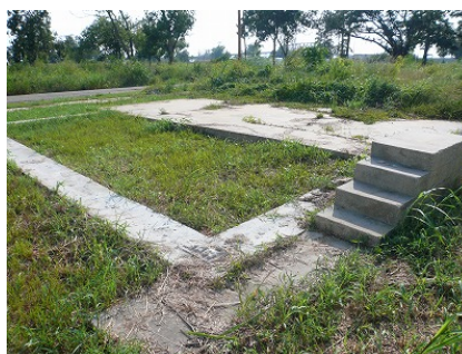
そこに残されたのは建物の基礎と玄関の階段のみ
