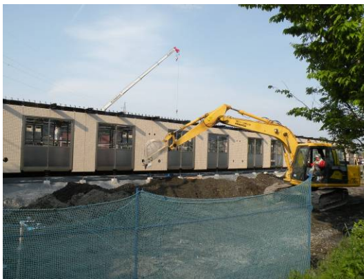
写真上:ふれあい食事会のひとコマ。焼きそばは食事会では大人気だった 写真下:建設中の仮設住宅。登米市内には今のところ2カ所に合わせて数百戸単位の仮設住宅が建設予定となっている
